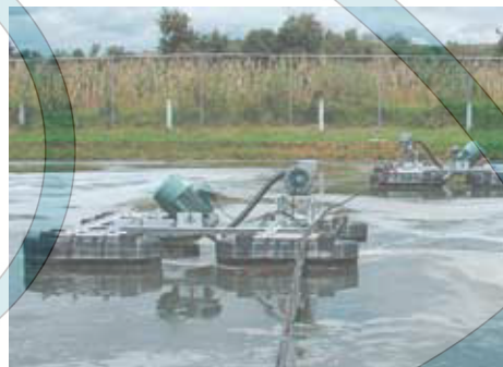
установка на плав-средстве(понтон)
