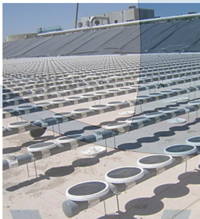
рис. 1 - установка диффузоров
