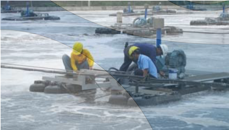
рис.5 - Рабочие производят плановый осмотр Process Aerator, пока остальные аэраторы продолжают работать. Нет надобности в спуске воды из резервуара или в грузоподъемных кранах.
