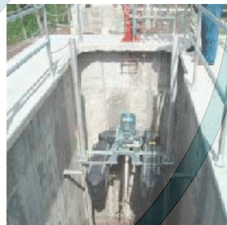
аэратор/миксер Triton на направляющих рельсах легко устанавливать и обслуживать
