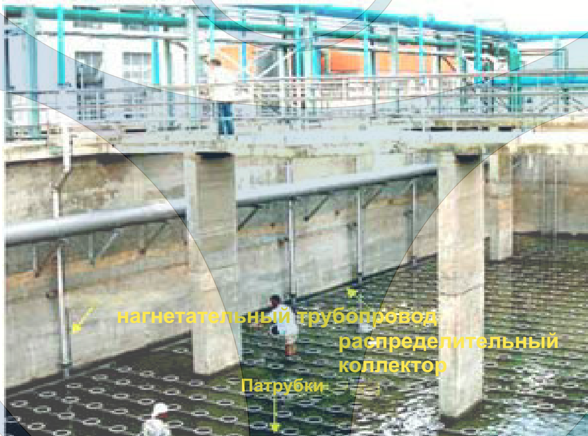
рис.2 - типичная прокладка труб для установки диффузеров
