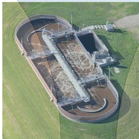
рис.4 - общий вид Process Aerator установленные на мост в оксидационном резервуаре.
