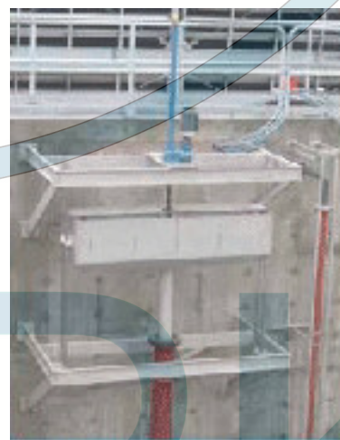
аэратор/миксер Triton на направляющих рельсах легко устанавливать и обслуживать
