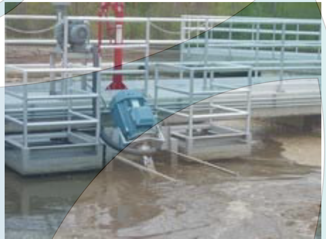
рис.6 - простота и безопасность в содержании и осмотре аэраторов благодаря сервисным платформам, используемых при установке на мост.
